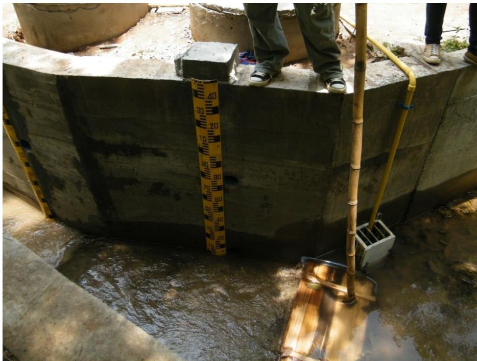
ภาพที่ 5 ภาพถ่ายอาคารวัดระดับน้ำแบบ Parshall flume ในพื้นที่ศึกษา
